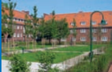
Liebevoll sanierter Demmlerhof
