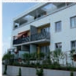
Umbau Pflasterbau Wuppertal Straße mit Architekten M&S
