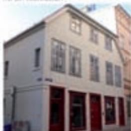
Sanierung Puschkinstraße 34 mit Architekten Bunnemann
