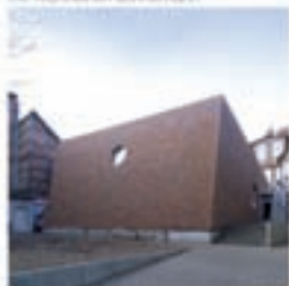
Neubau Synagoge Schwachherweg mit Architekturbüro Bernicke
